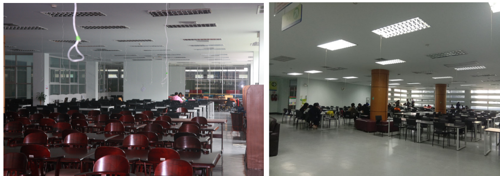
ภาพที่ 1 ปรับพื้นที่อ่านหนังสือเป็นหลอดชนิดกระตุก เปิด-ปิดโคมเดียว
